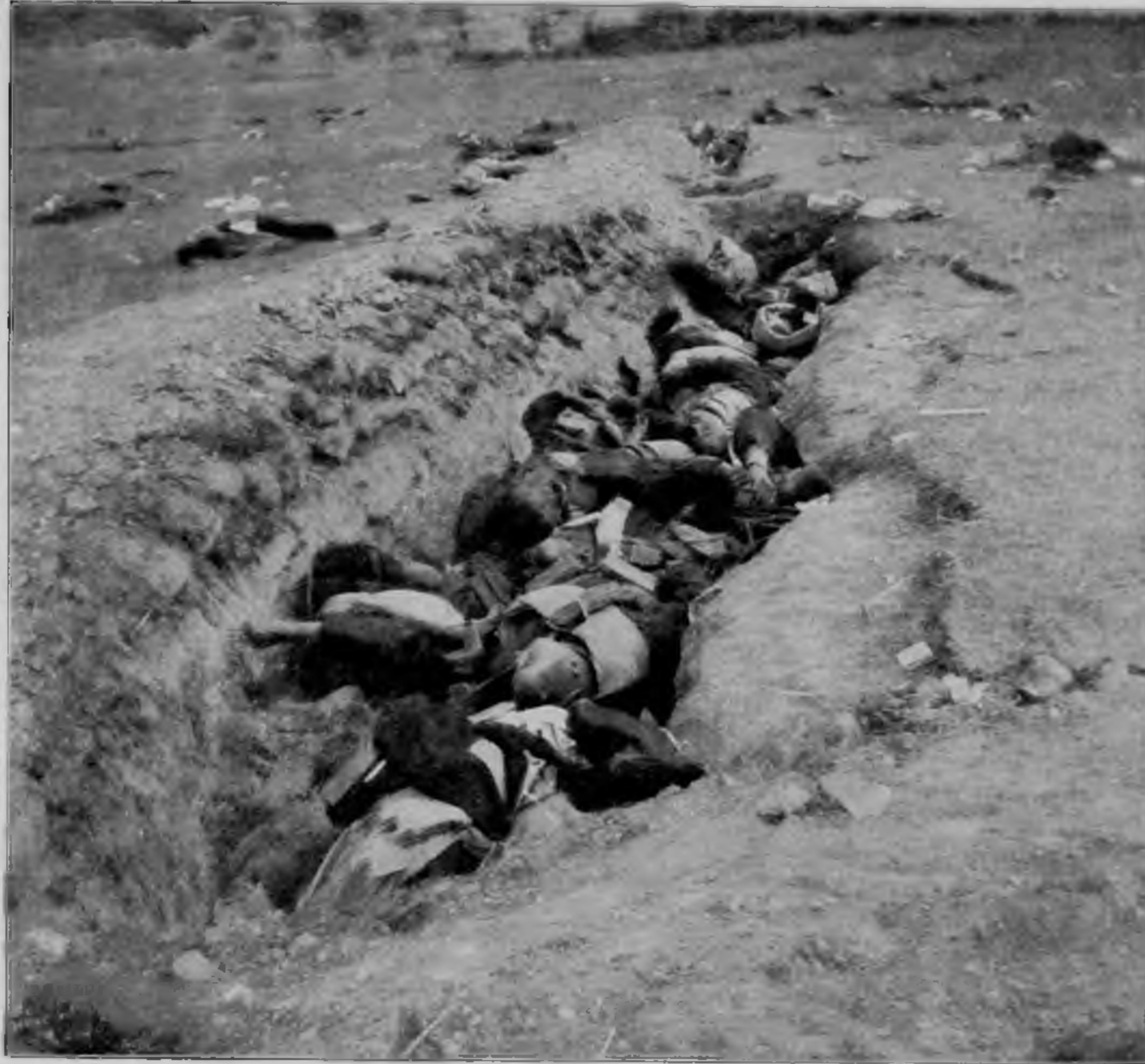
Траншея на сигнальной горѣ Шоушань.
