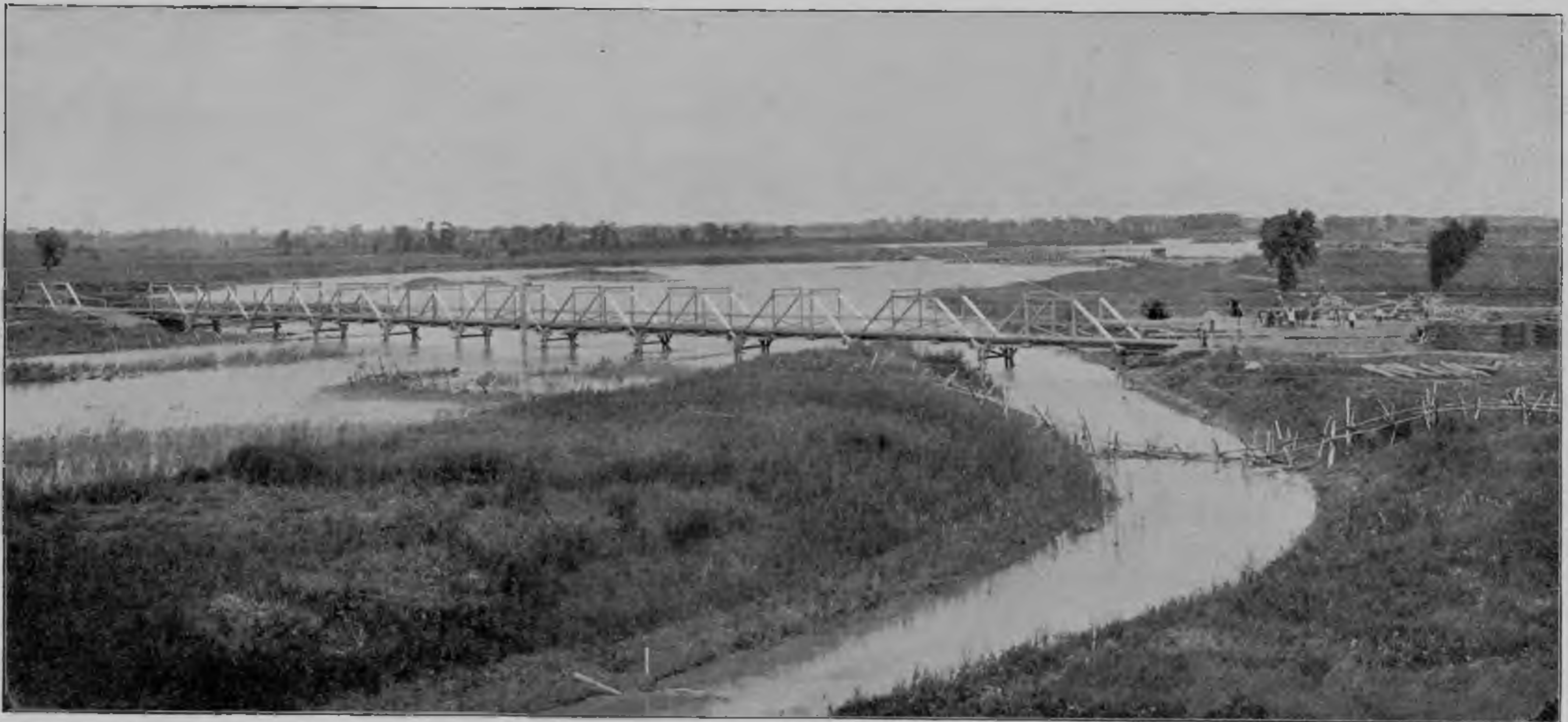
Мостъ черезъ р. Да-ляохэ у ст. Гунчжулинь.
