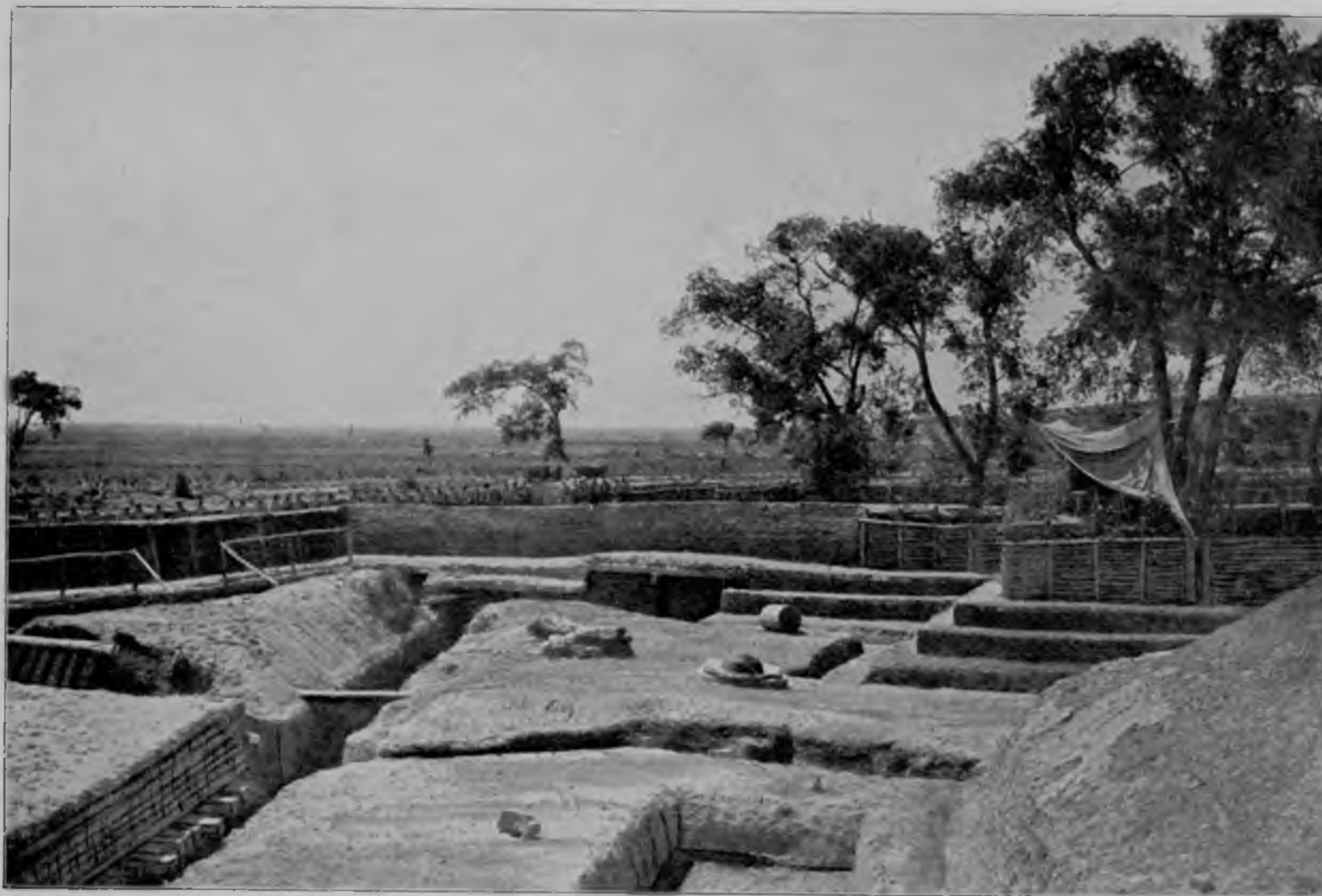
Постройка редута на главной Сыпингайской позиции.
