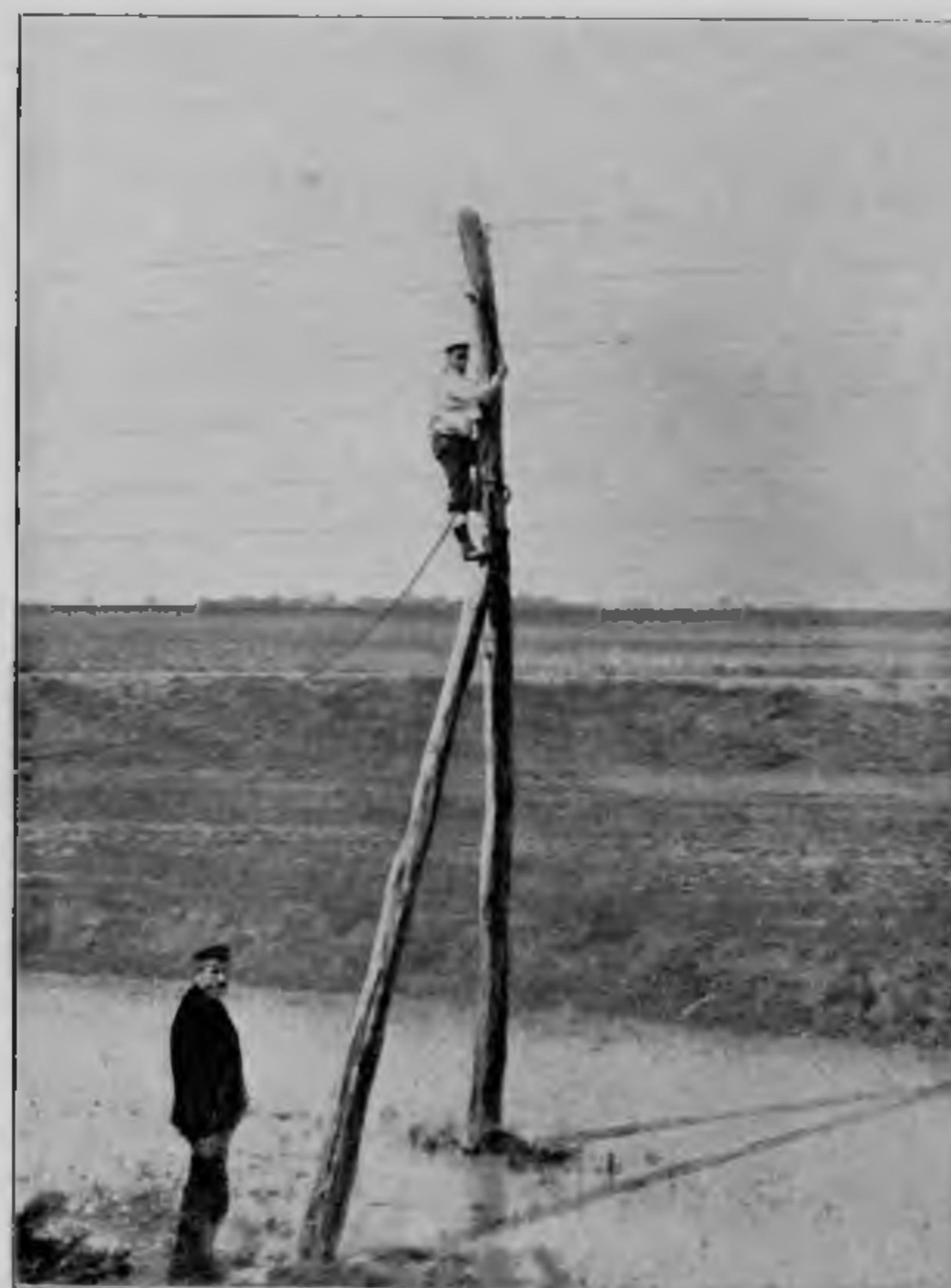
Прокладна телеграфной лини.
