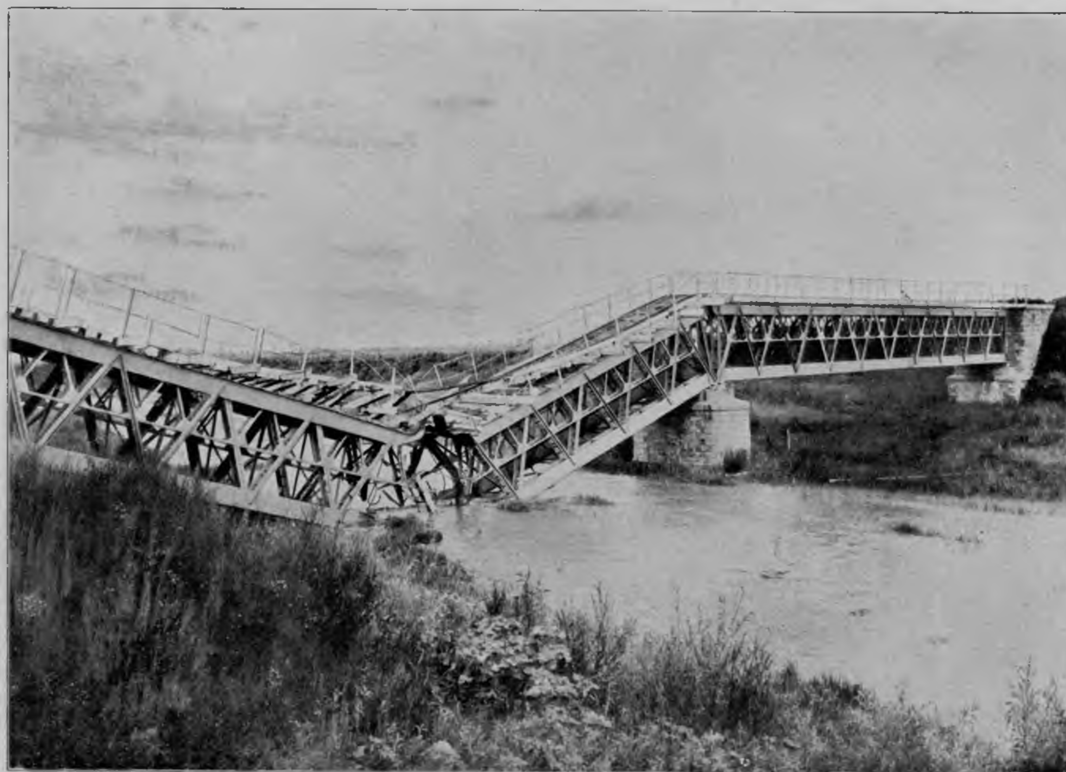
Разрушенные ж. д. мосты.
