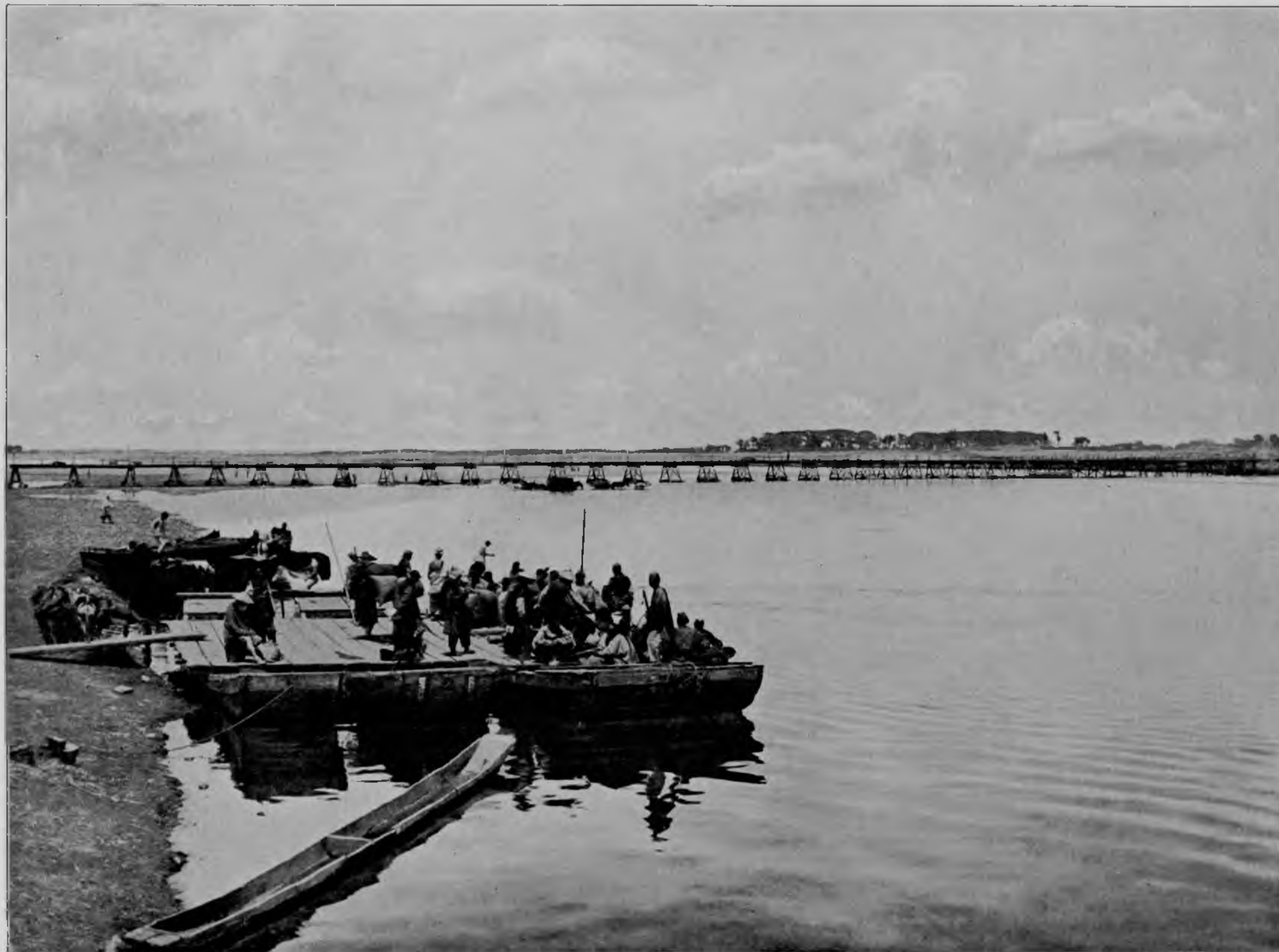
Мостъ на козлахъ черезъ рѣку Тайцзыхэ.
