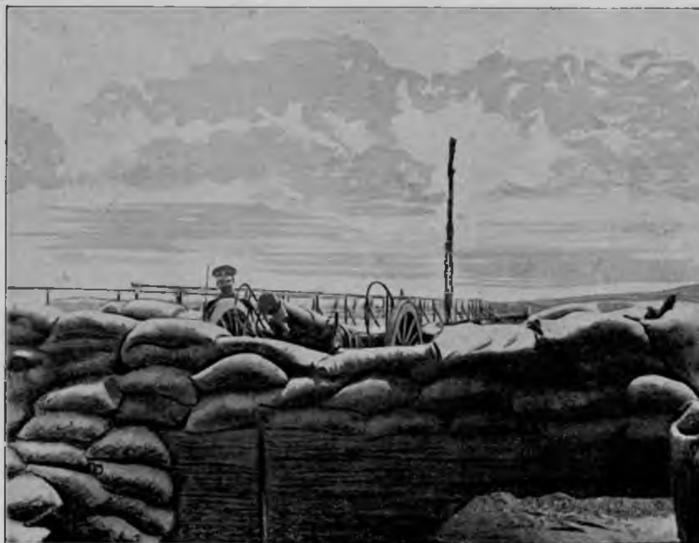
На охранѣ моста черезъ р. Тайцзыхэ.
