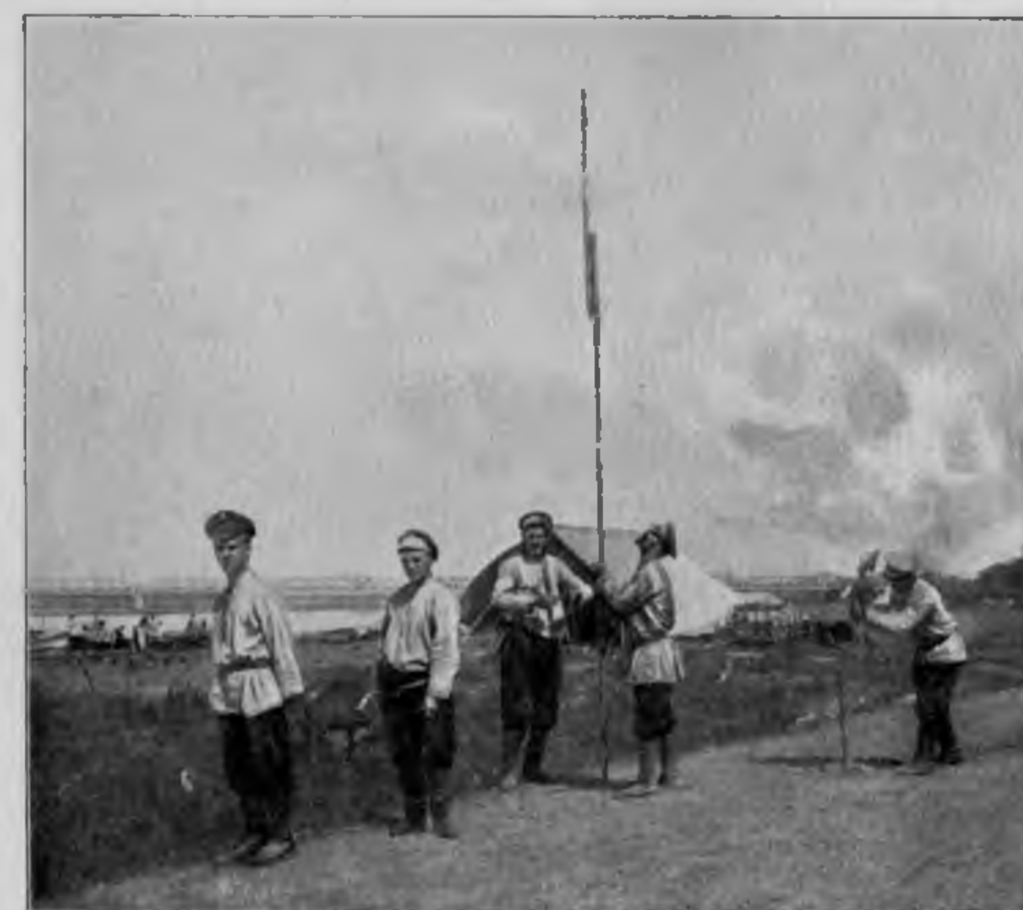
Прокладка полевого телеграфа.
