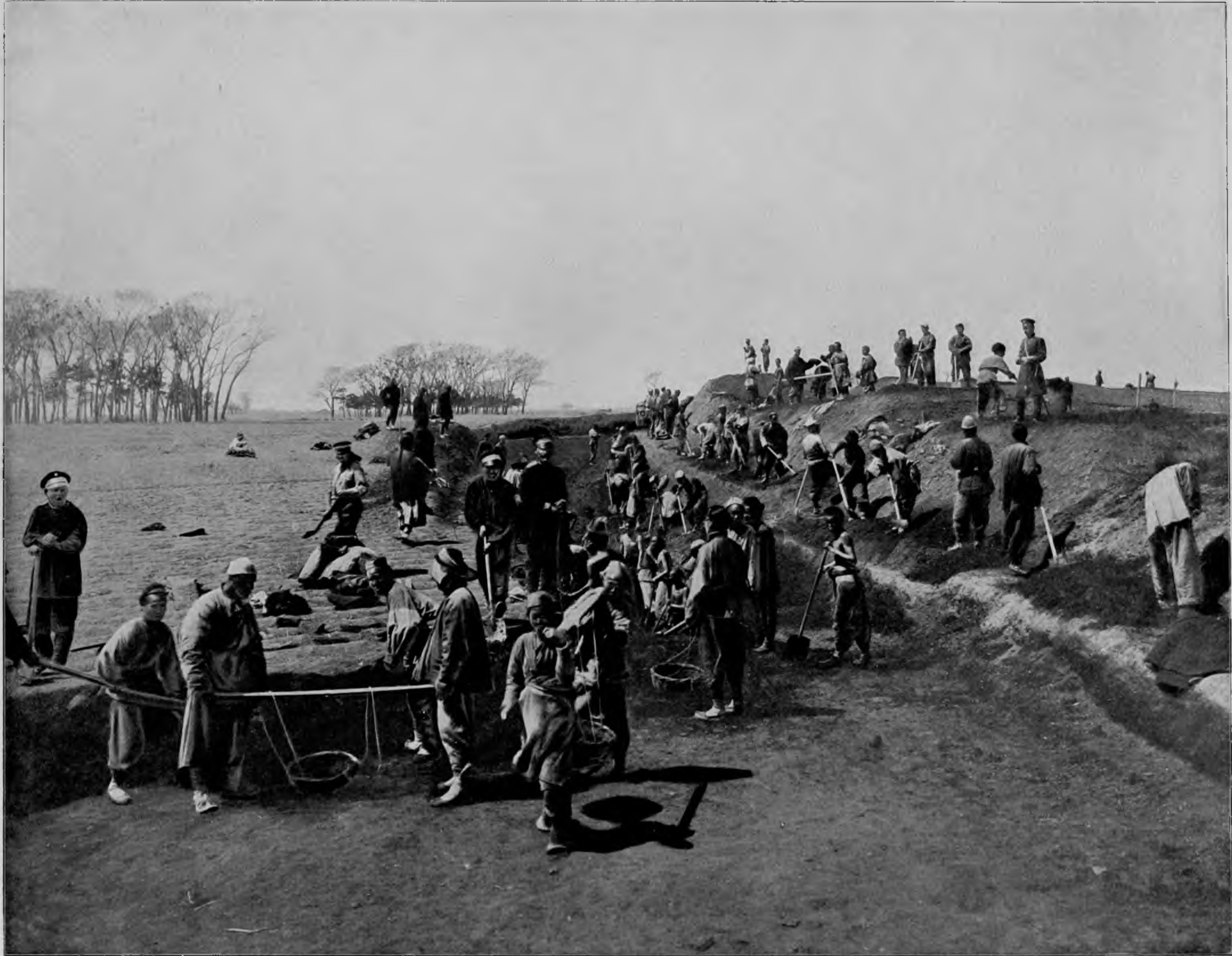
Постройка редута между 3 и 4 фортами на главной Ляоянской позиции.
