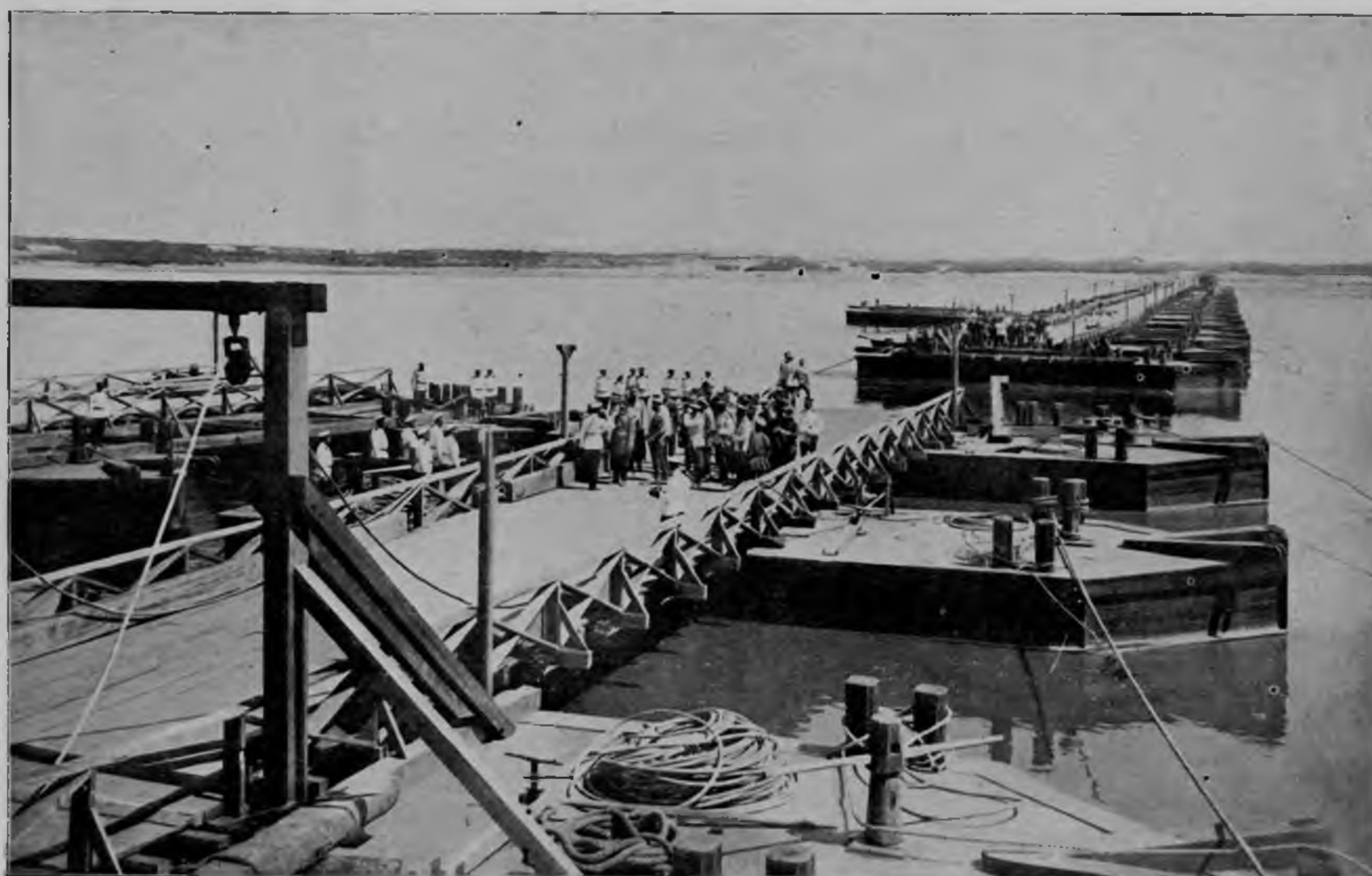
Понтонный мостъ, наведенный черезъ р. Сунгари у Лошагоу.
