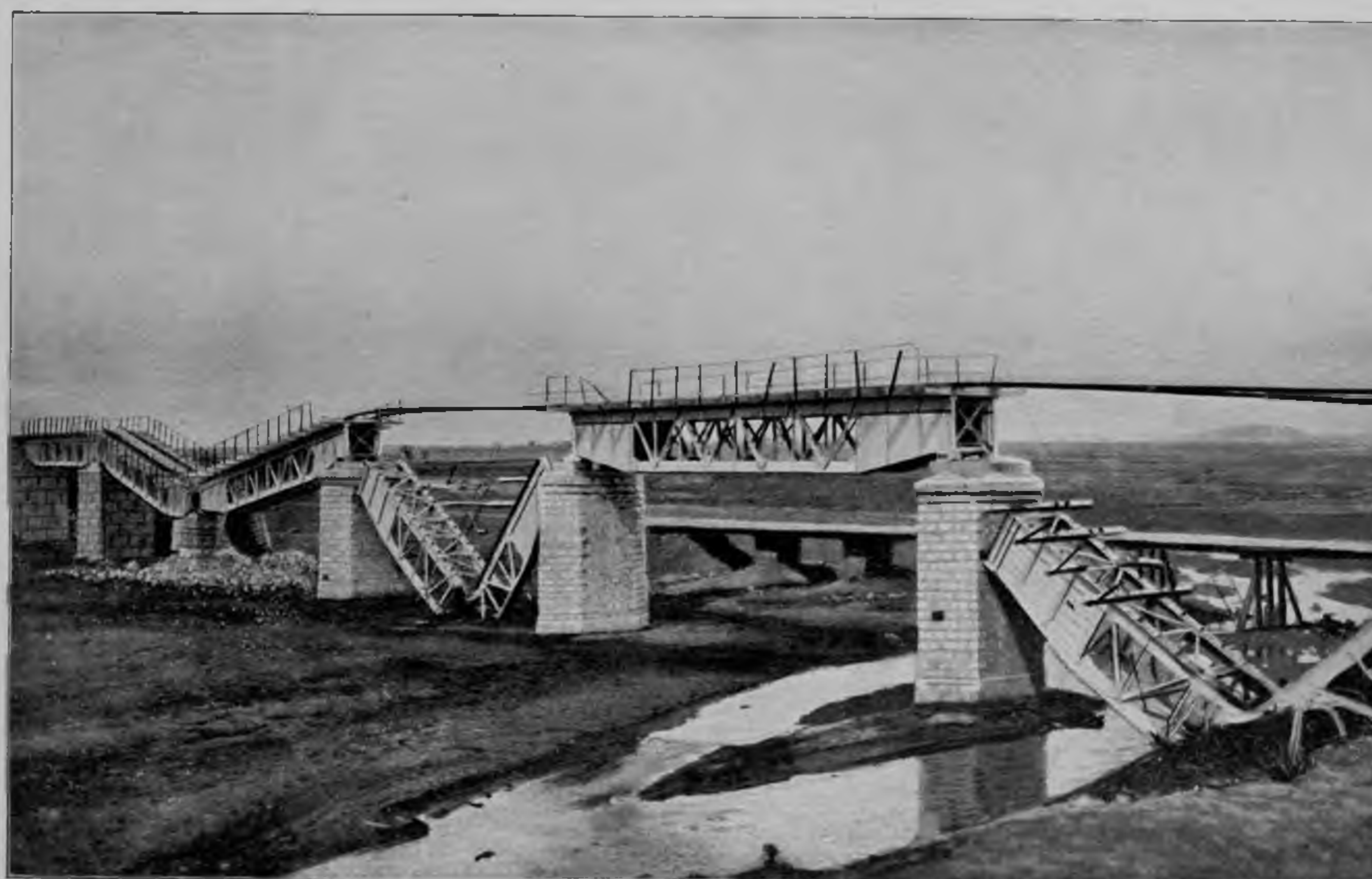
Разрушенный ж. д. мостъ.
