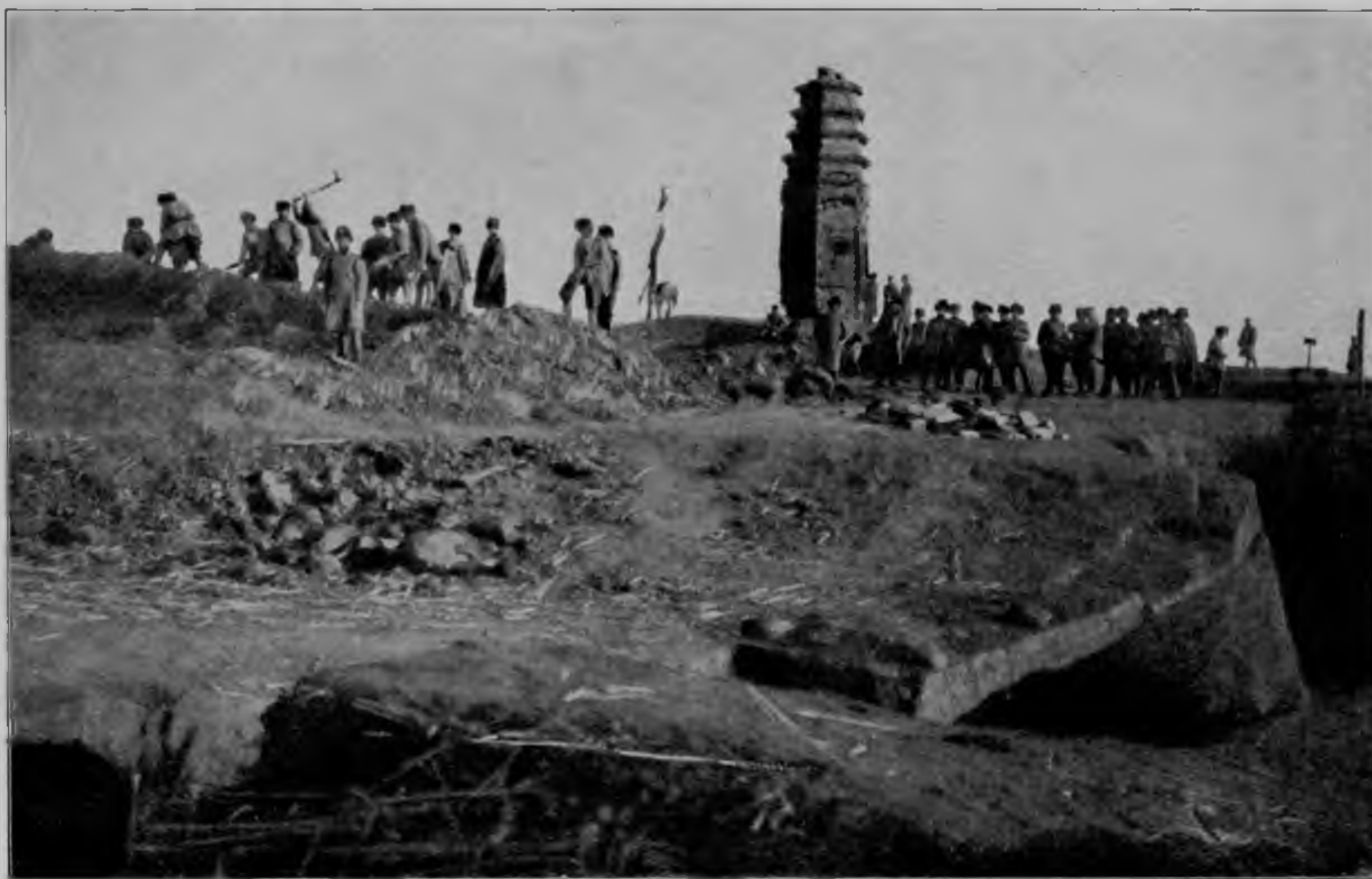
Постройка редута у башни Хоуди.
