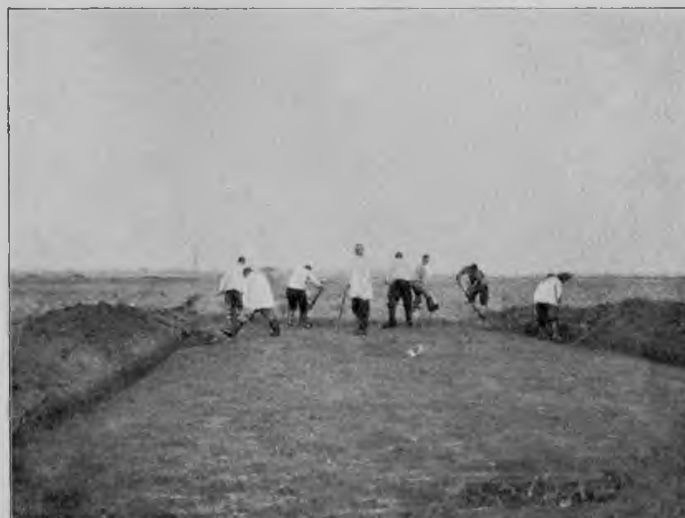
Прокладка колоннаго пути.
