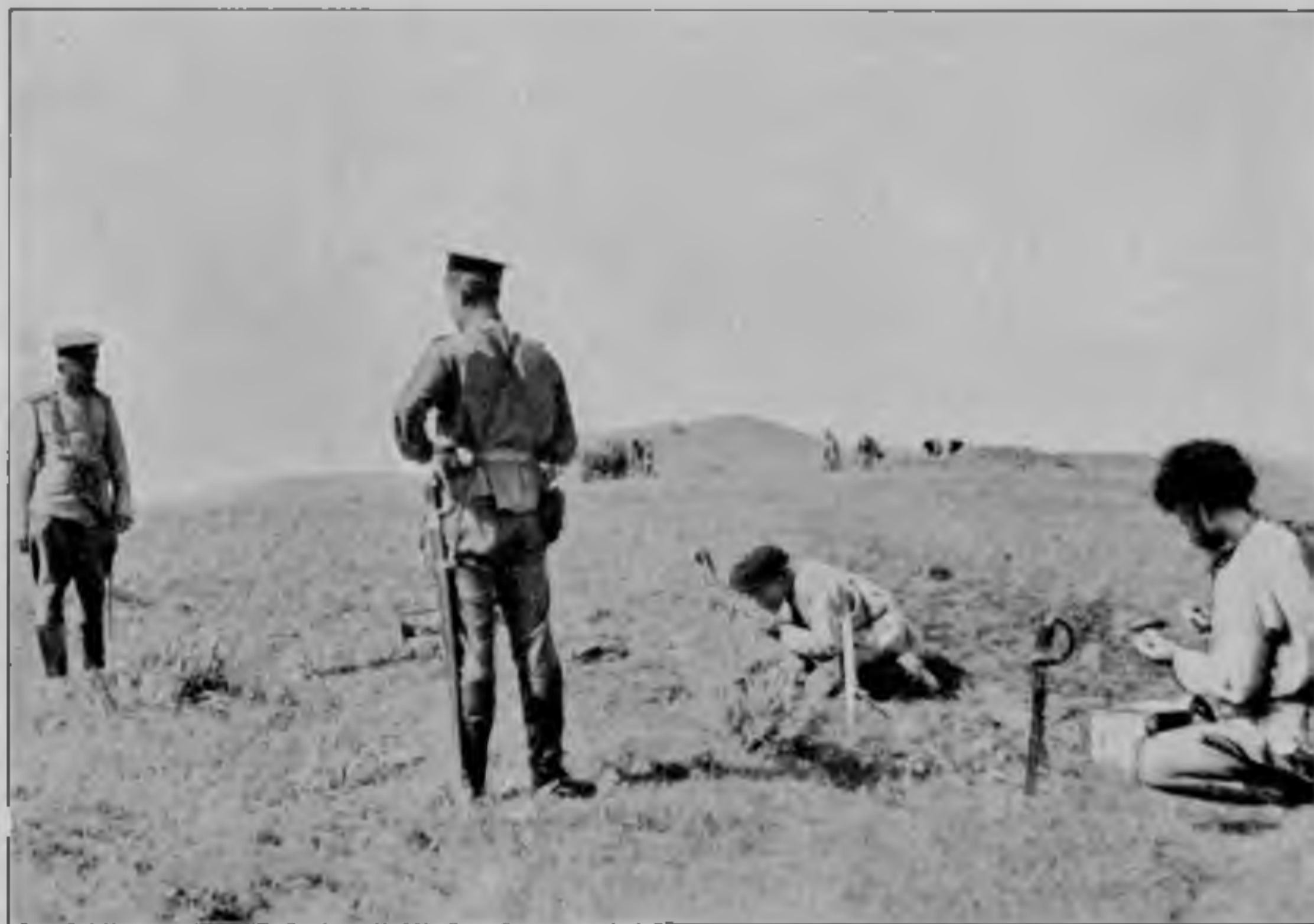
Установка телефонной станціи.
