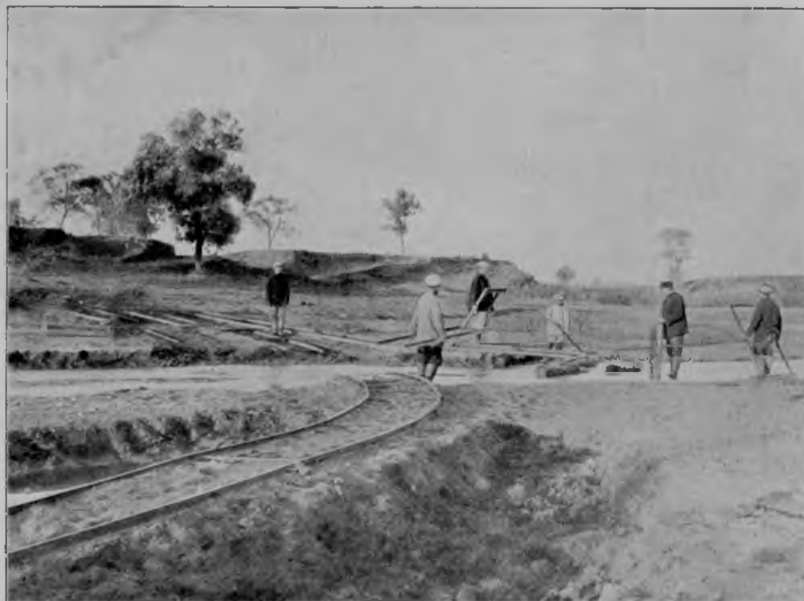
Постройка конно-желѣзной дороги Гунчжулинъ-Херсу. У Эршиядзы.
